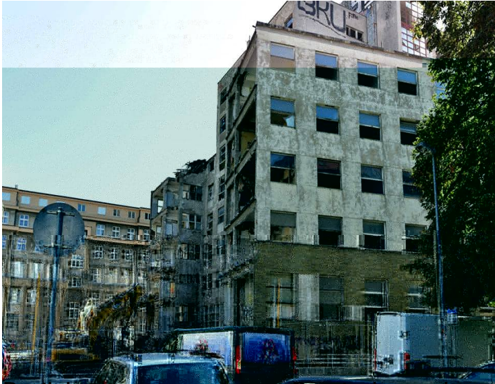
Bratislava Prestavba a rekonštrukcia objektu Bezru ová 3 a 5 Prestavba a rekonštrukcia objektu Bezru ová 3 Bratislava Staré Mesto, rekonštrukcia objektu rekonštrukcia objektu pod
